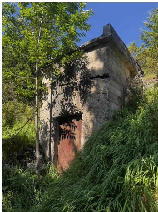
Sl. 2.12.2. Postojeći sabirni rezervoar Razvršje
