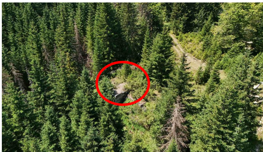
Sl. 2.12.1. Lokacija sabirnog rezervoara Razvršje (van zone NP)
