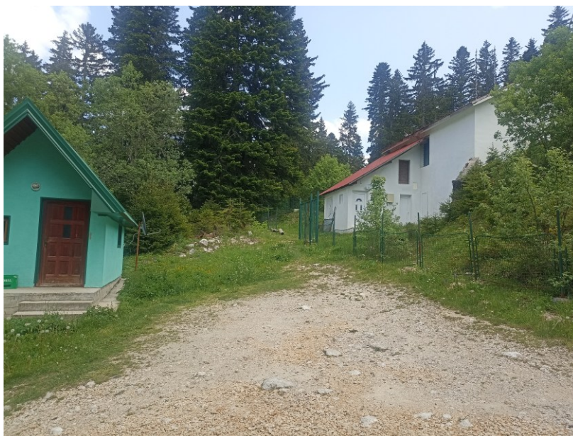
Sl. 2.12.3. GG bazen (čuvarska kućica i upravna zgrada)
