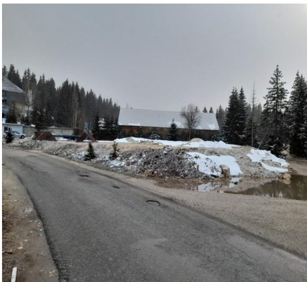
Slika 4 :Postojeće stanje na lokaciji
