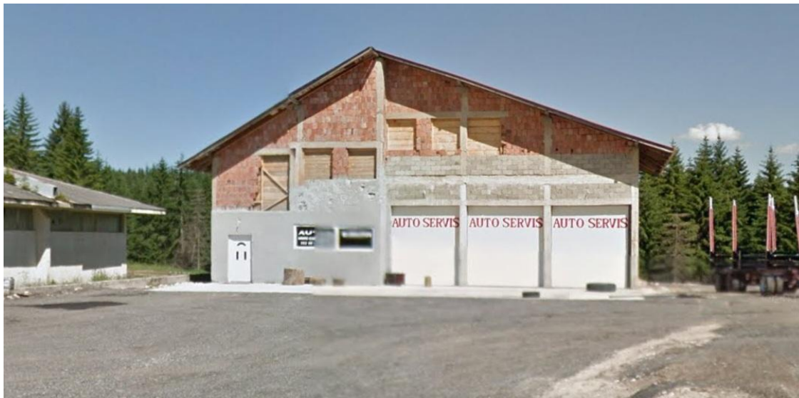
Slika 5. Objekat auto servisa
