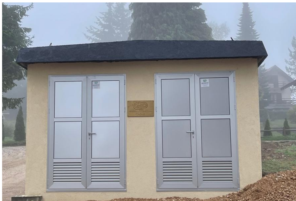
Slika 7. Primjer građevinskog objekta trafostanice
