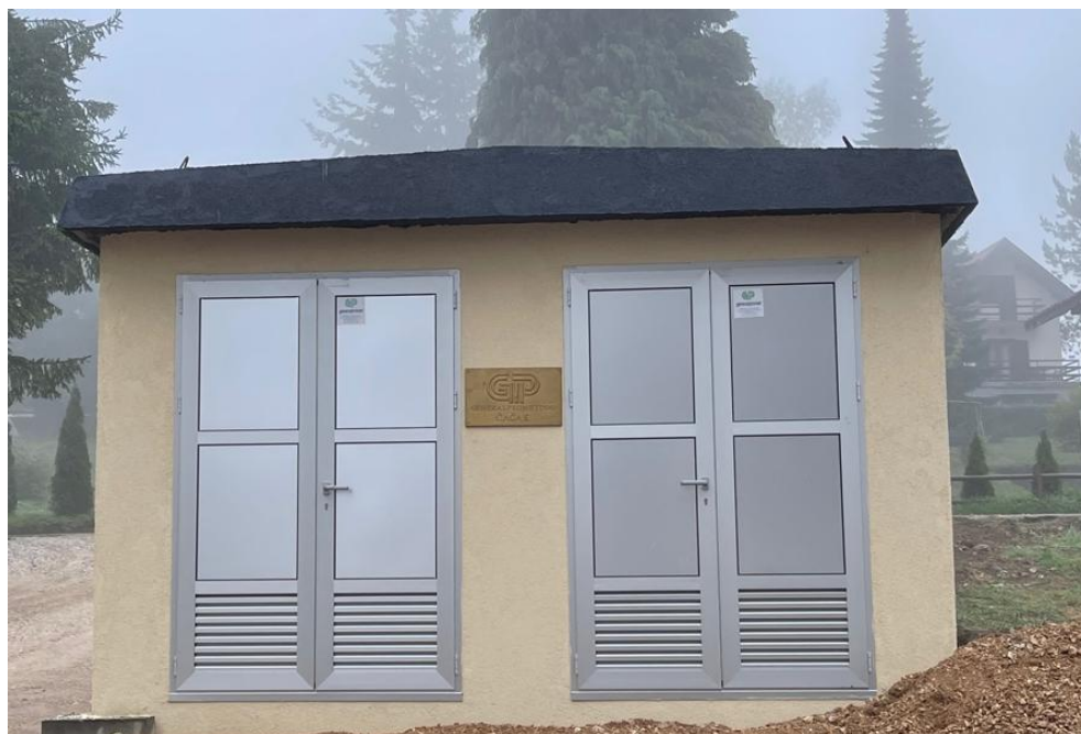
Slika 7. Primjer građevinskog objekta trafostanice
