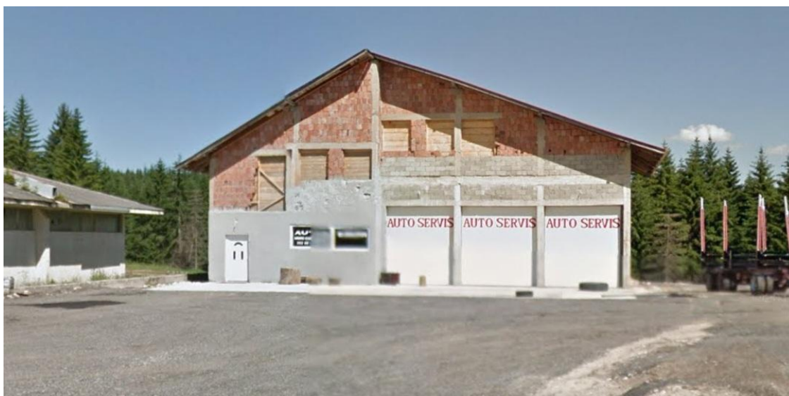
Slika 5. Objekat auto servisa
